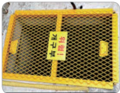
▶ 견고한 개구부 덮개 설치
