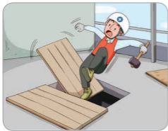
▶ 덮개 설치 불량
